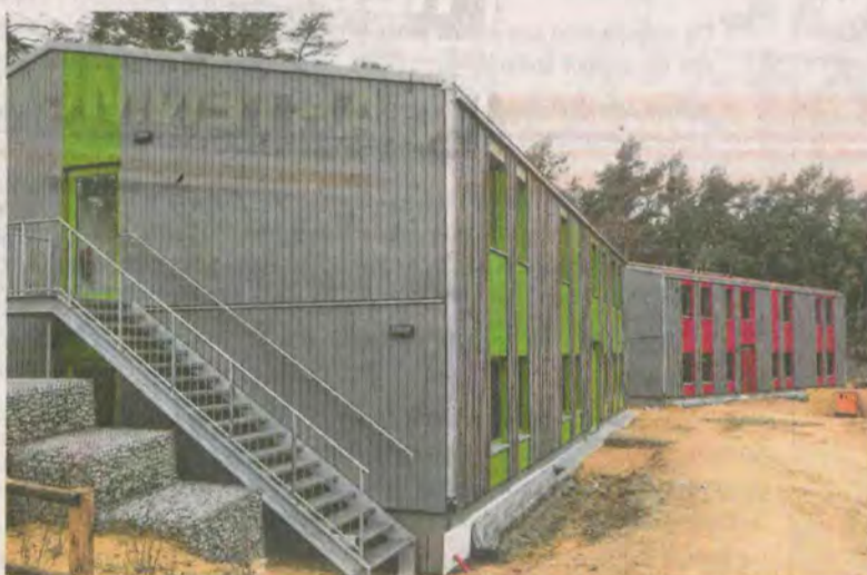
Die Waldhütte (vorn) und der Fuchsbau: ein Blick auf die zwei neuen Bettenhäuser, die jeweils elf Zimmer und 32 Betten bieten
