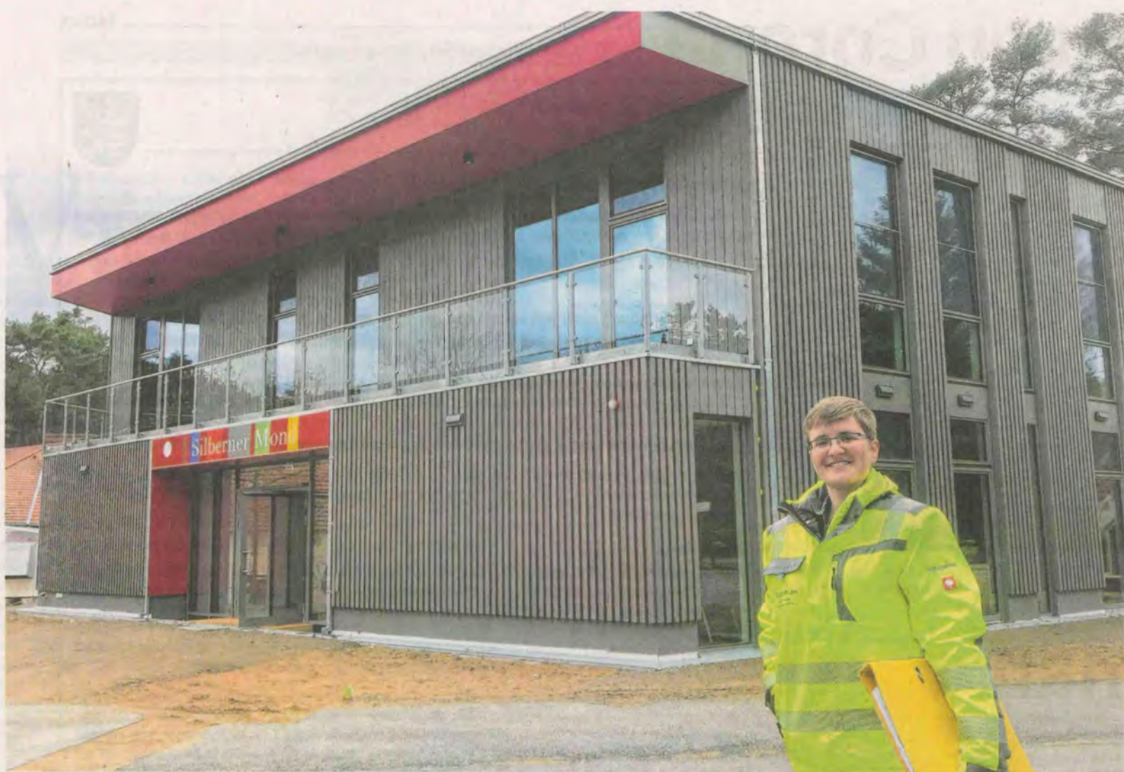
Die Bauüberwacherin: Ingenieurin Bianca Schmidt hat auf dem Hirschluch-Gelände nicht nur das Haus „Silberner Mond“ im Blick, sondern noch vieles mehr.
